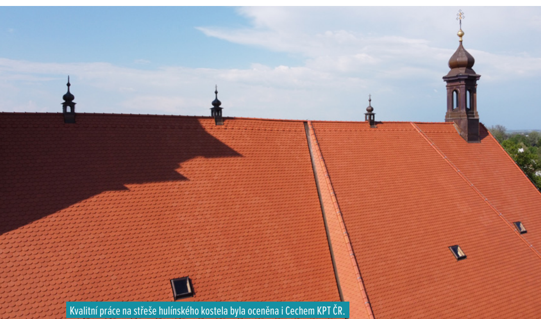
Bobrovkami krytá střecha hlavní lodi na kostele v Hulíně.
