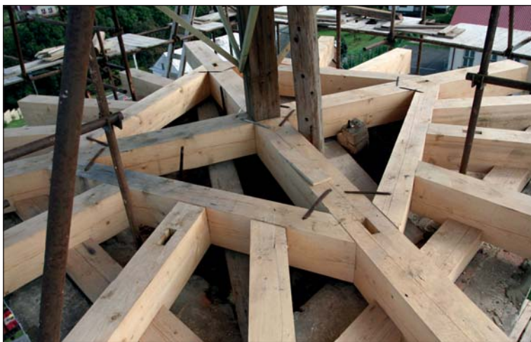
3) Detail nové tesařské konstrukce věže kostela sv. Jiří ve Vrchách
