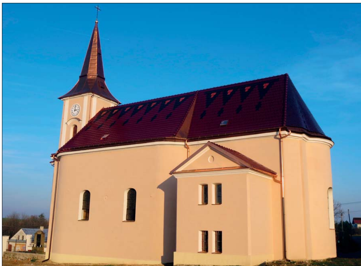
4) Kostel sv. Jiří ve Vrchách po dokončení střechy i fasády
