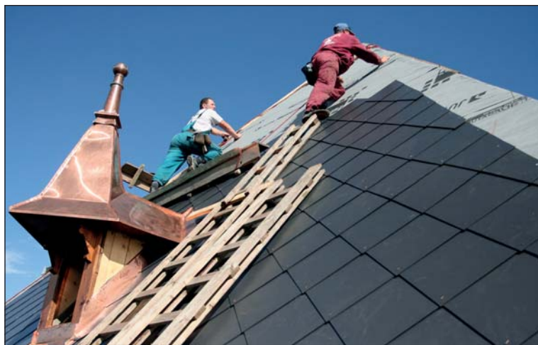
1) Práce na střeše kostela sv. Anny v Polance nad Odrou, s eternitovou krytinou
